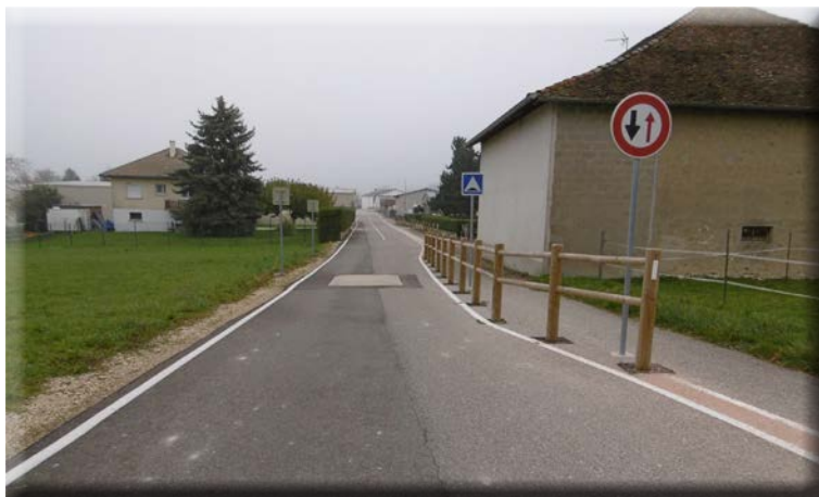
ROUTE DE LA SINIÈRE : TRAVAUX ACCESSIBILITÉ ET SÉCURITÉ
